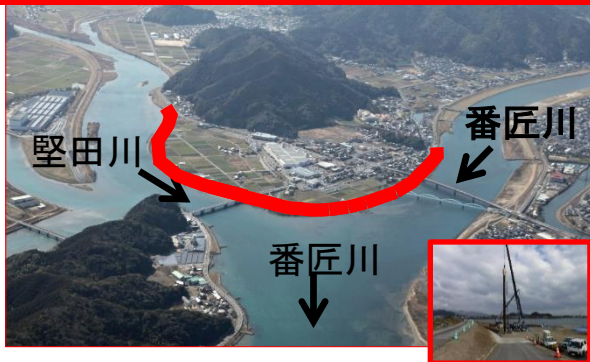
国：大規模地震発生時の堤防沈下対策
